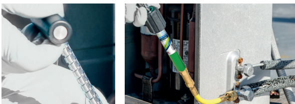
Injektion des Färbemittels durch Drehen des Griffs.
