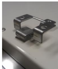
Detail eingehängte Deckenhalter
