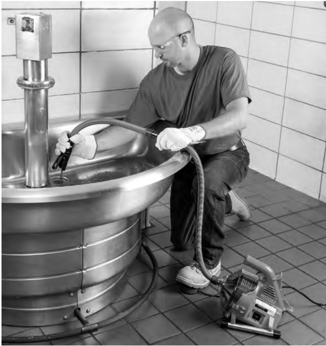
Obrázok 11 – Vyťahovanie špirálového kábla
