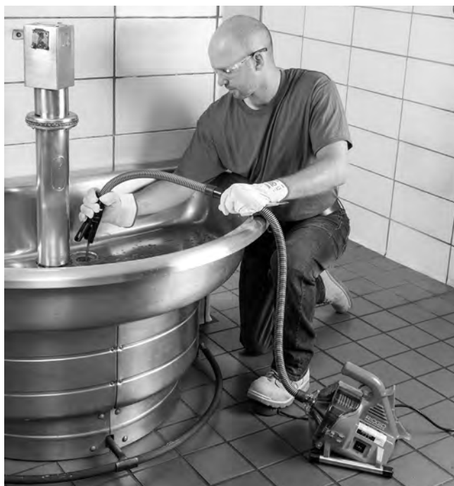
Slika 11 - Povlačenje sajle
