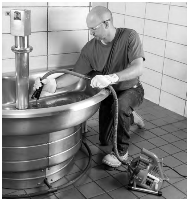
Obrázek 11 – Vytažení kabelu
