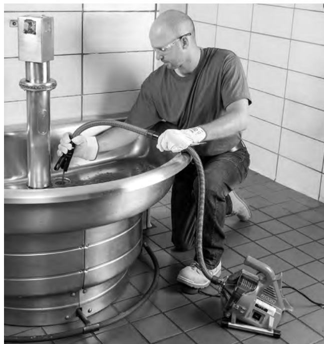
Figur 11 - Tilbagetrækning af spiralen
