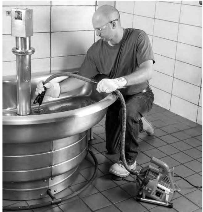
Figur 11 – Trekke ut kabelen
