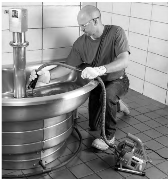
11. ábra – A kábel kihúzása
