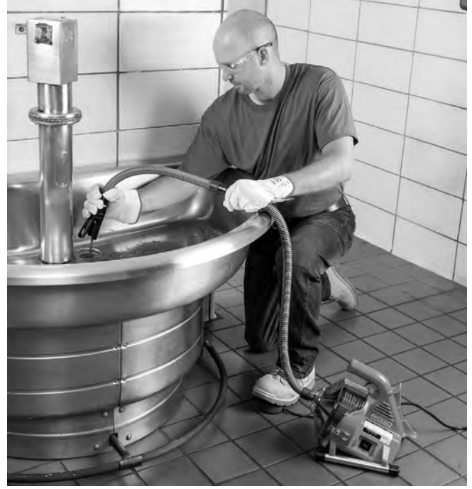
Şekil 11 – Kablonun Geri Toplanması
