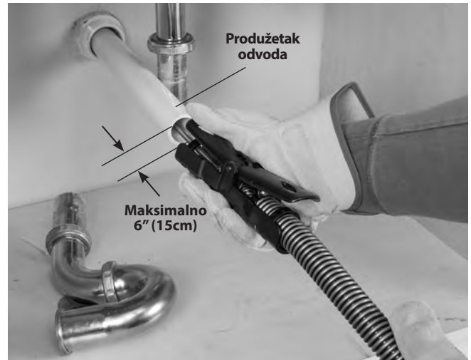
Slika 7 – Primer produženja odvoda do daljine od 6" (15 cm) od AUTOFEED jedinice.
