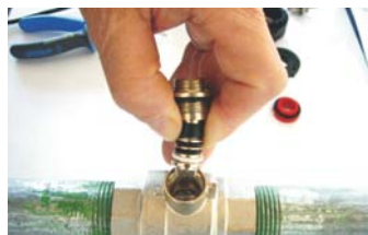
Ersetzen Sie die alten Satz mit einer neuen. Axis zu dem Schlitz in Kugel einsetzen. Immer den neuen kompletten Spindeldichtungssatz Verwenden!
