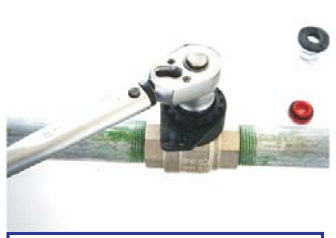
Die Mutter Verschrauben Sie mit Drehmomentschlüssel M = 23Nm
