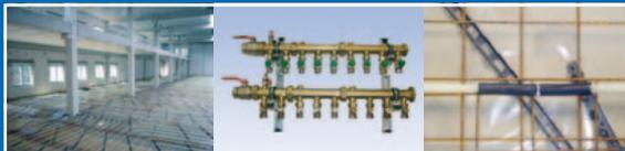
**Industriebodenheizung – Robust für hohe Belastungen.**
