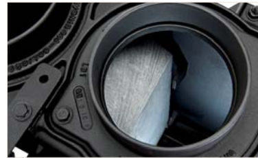
Specksteinkern im GSK Blick von oben durch den Stutzen
