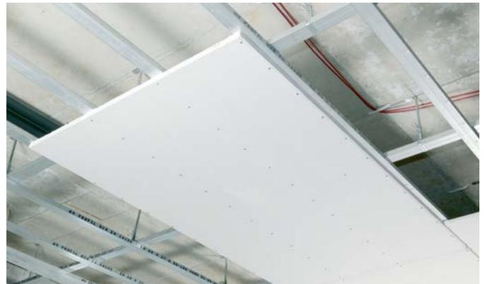
Abb. 4-5 Montiertes Deckenelement
