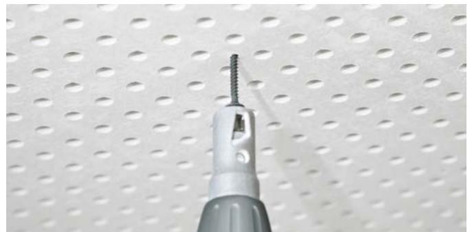
Abb. 5-21 Montage mit Trockenbauschrauber mit Tiefenanschlag
