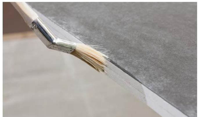
Abb. 5-17 Kanten grundieren
