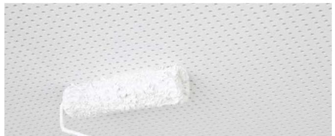
Abb. 5-27 Auftragen der Farbe mit einem Farbroller
