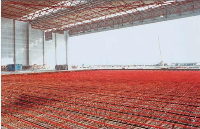
Abb. 7-1 Flächenheizung in einer Industriehalle
