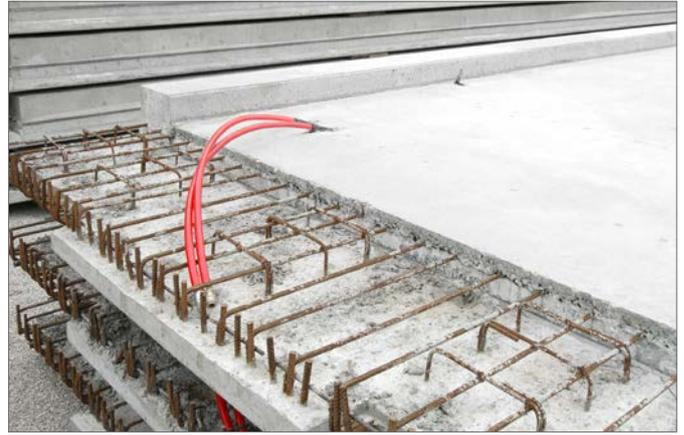
Abb. 6-4 REHAU BKT in Halbfertigteil
