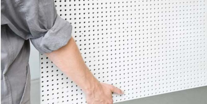
Abb. 5-11 Manuelles Handling der Akustikkühldeckenelemente auf der Baustelle
