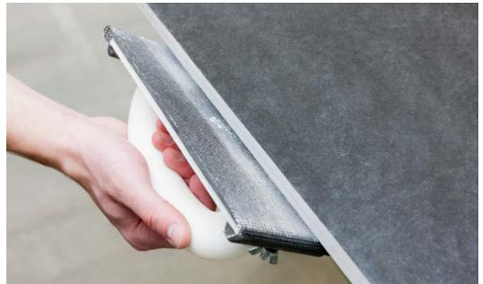
Abb. 5-16 Kanten anschleifen
