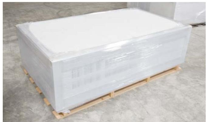
Abb. 5-10 Anlieferung und Lagerung der Akustikkühldeckenelemente
