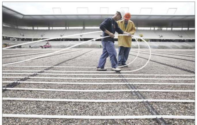
Abb. 10-3 Heizungsrohre verlegen
