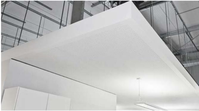
Abb. 5-7 Beispielhafte Ausführung eines Deckensegels
