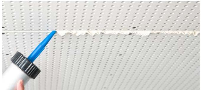
Abb. 5-23 Vollständiges Ausfüllen der Fuge über die gesamte Elementstärke von 20 mm
