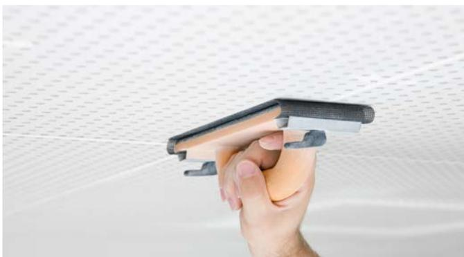
Abb. 5-26 Oberfläche schleifen
