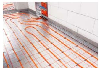
**7** Abschließend den Heizkreis nach Vorgabe des Systems Rohrhalteplatte RAUTAC 10 installieren.
