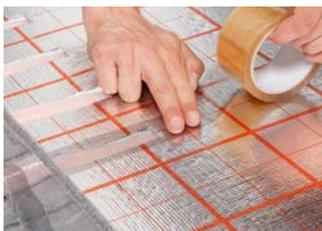
**4** Die Ausschnitte der Rohrhalteplatte RAUTAC 10 in Längsrichtung mit Klebeband so abkleben, dass kein Estrichanmachwasser hineingelangen kann.
