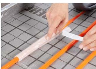
**2** RAUTHERM iso Streifen eng um das Heizrohr wickeln und mit der selbstklebenden Überlappung verkleben.
