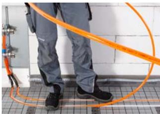
**4** Vor- und Rücklauf des ersten Heizkreises sowie Heizkreis selbst installieren.
