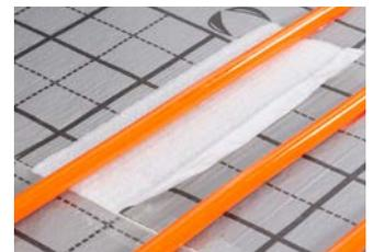
**1** RAUTHERM iso Streifen unter das Heizrohr positionieren.
