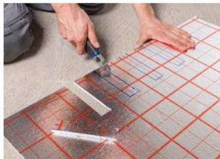
**2** Im Bereich der Türdurchführung die Rohrhalteplatte RAUTAC 10 ca. 15 cm lange und ca. 3 cm breite Rechtecke ausschneiden, sodass Reststege zwischen den „auftauchenden“ Rohren verbleiben.
