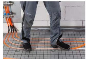
**7** Vor- und Rücklauf des zweiten Heizkreises sowie Heizkreis selbst installieren. Nachfolgende Heizkreise wie vorab beschrieben nacheinander installieren.
