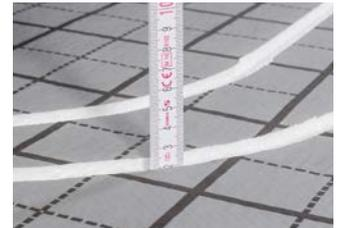
Hinweis: Die Tiefe der Nut ist 20 mm zw. Oberkante Dämmung und Scheitel Nut.
