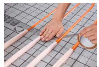
**5** Bei Bedarf die Rohre in der Dämmebene zusätzlich mit Klebeband befestigen.
