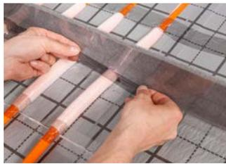
**7** Das Dehnfugenprofil auf der Heizkreisseite mit Klebeband so abkleben, dass kein Estrichanmachwasser hindurch gelangen kann.
