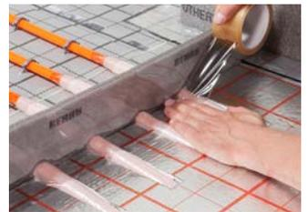
**3** Die Ausschnitte der Rohrhalteplatte RAUTAC 10 in Querrichtung mit Klebeband so abkleben, dass kein Estrichanmachwasser hineingelangen kann.
