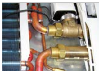
Ausführung 2-Wege-Ventil WLT 25-2 bis 85-2
